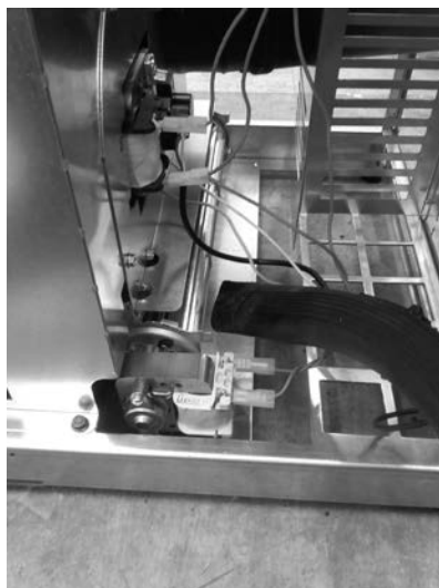
Fig. 65 - Room fan cleaning
